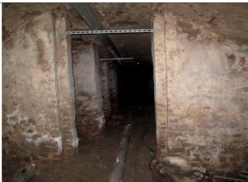
Een blik in de voorste kelder van Korenbrugstraat 14, met links daarin de als steunberen werkende muren. (Foto: BAM)
