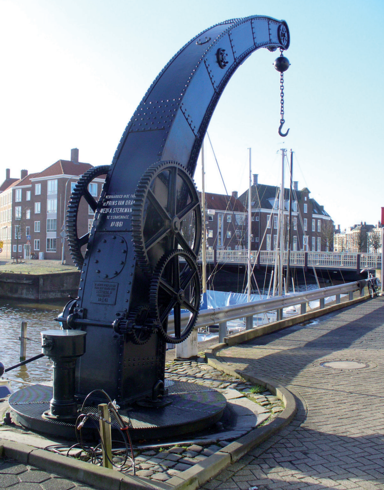
De Fairbairnkraan zoals die nog steeds in Middelburg aan de Rotterdamsekaai te zien is. (Foto: Ad van Drunen, 2013)
